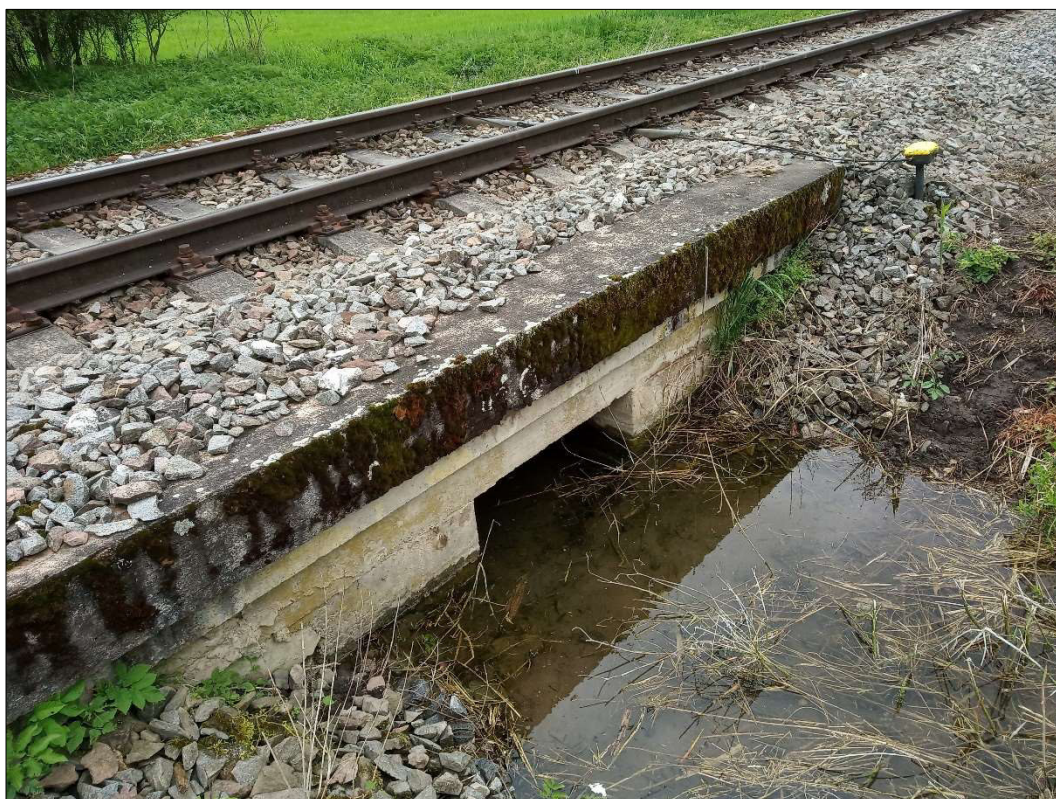
Obr. 13: Propustek v drážním km 6,759 určený k rekonstrukci
